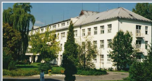
Chirurgický pavilón (postavený 1933/ súčasne generálna rekonštrukcia)
